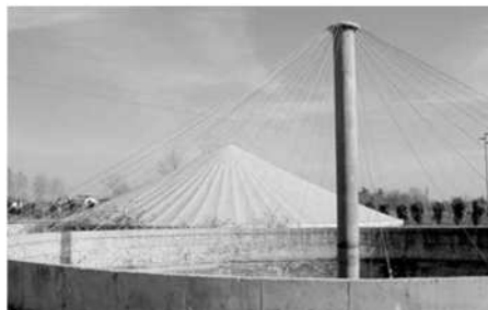
Copertura con teli fissati ai bordi della vasca liquami e sostenuti da un pilastro centrale.
