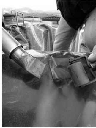
SALDATURA mediante apposite attrezzature
