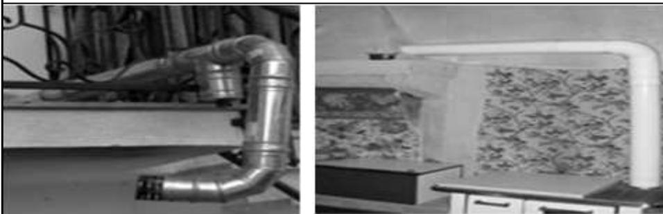
In questa installazione lo scarico fumi di una stufa a pellet è, nella prima parte, completamente orizzontale, per poi, addirittura, inclinarsi verso il basso.
