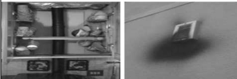
Scarico fumi di una stufa a pellet passante tramite un mobile in legno forato al centro ma privo di alcun isolamento termico. Situazione pericolosa a causa delle elevate temperature della canna fumaria, vicinissima, se non a diretto contatto, a fonti infiammabili senza alcuna protezione. Si tratta di un'installazione **non a norma** e soprattutto **non in sicurezza**.
