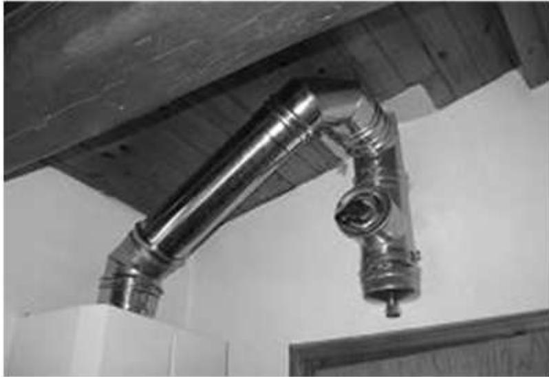
Lo scarico presenta un contatto diretto con materiale combustibile **ed inoltre il canale da fumo ha il tratto verticale di lunghezza inferiore a due diametri della bocca di scarico.**
