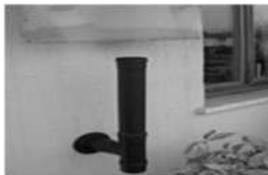
Scarico a parete per stufa a pellet, **VIETATO** dalla **Uni 10683**, senza alcun terminale anti-intrusione.
