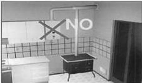
**È vietato convogliare nello stesso canale da fumo lo scarico di apparecchi a gas ed i canali provenienti da cappe sovrastanti gli apparecchi di cottura.**
