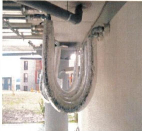
**Giunto flessibile** per il collegamento dell'impianto termico di riscaldamento
