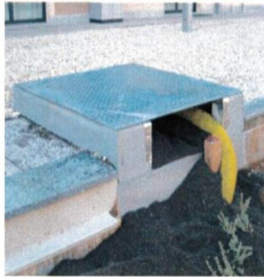
**Giunto flessibile** per il collegamento della fornitura del **gas**
