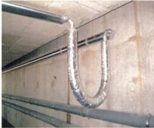
**Giunto flessibile** per il collegamento dell'impianto idrico dell'edificio all'acquedotto cittadino
