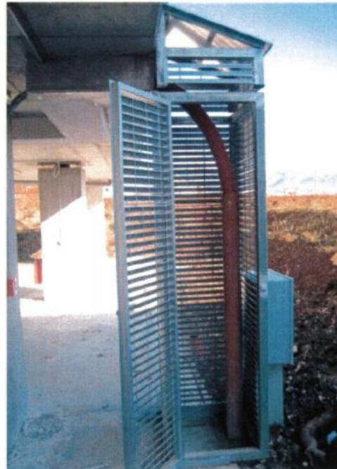
**Giunto flessibile** per il collegamento della fornitura elettrica dell'edificio al cavidotto dell'Enel
