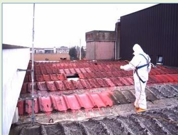
Bonifica mediante confinamento (sovracopertura) + incapsulamento
