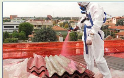
Bonifica mediante incapsulamento (resine-bicolore)
