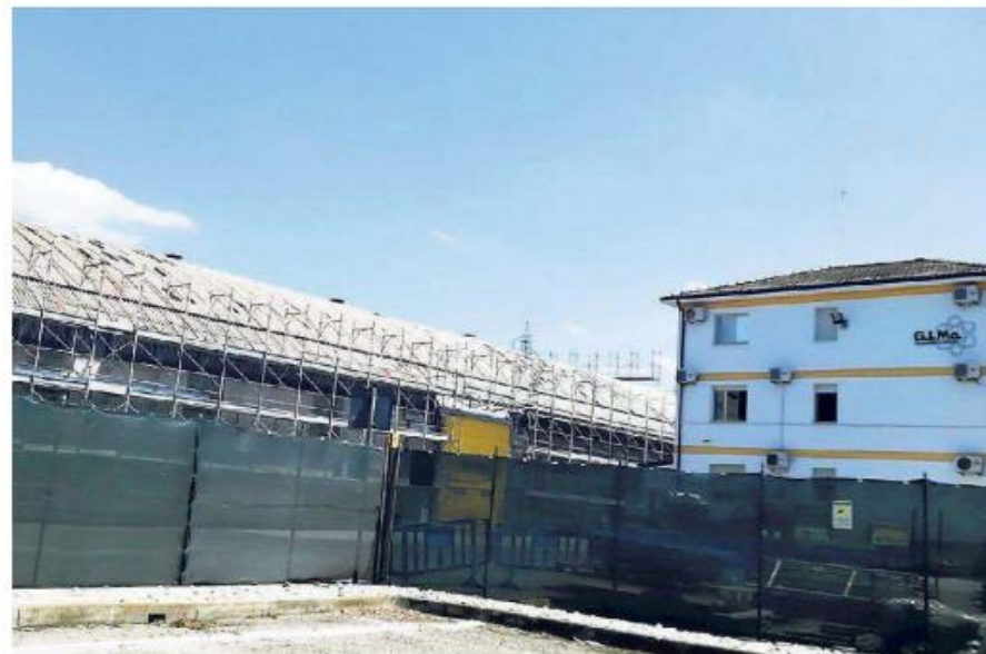
Il cantiere aperto alla Gima di Rubiera per la bonifica dall'amianto
